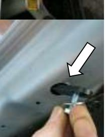
3. Вкрутить в планку закладную на несколько оборотов болт M6x16 с шайбой 6 ув., (Рис.3).
